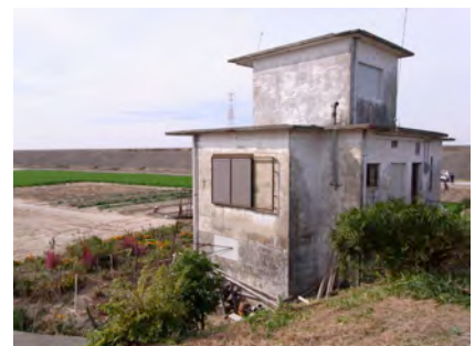
堤防法面中腹から出入りする玄関
