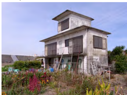
平坂干拓における復興住宅南東側外観
