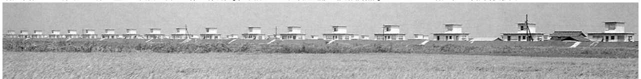
鍋田千拓「第二線堤防」超しに復興住宅を望む
