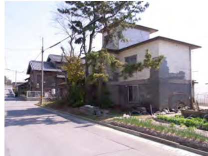
川口干拓における復興住宅北西側外観
