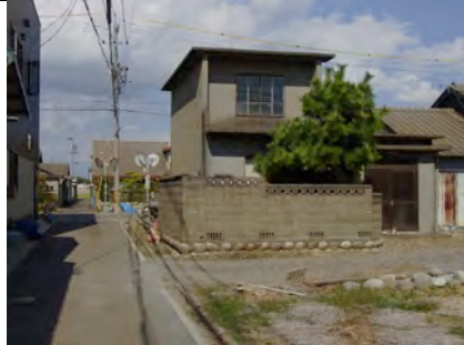
城南干拓における復興住宅南西側外観
