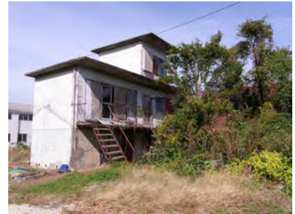
南側バルコニー直通階段の一例
