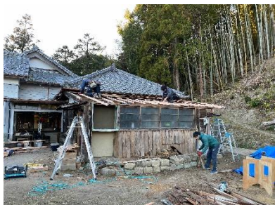
写真6 屋根修繕WSの様子
