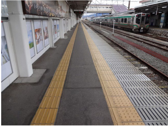
写真 36. ホーム上に誘導ブロックを設置している (JR 会津若松駅)
