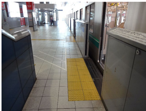
写真 41. ホームドアの前の点字ブロック 3 (JR 浦和美園駅)
