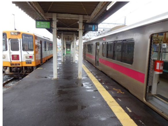
写真 17. 島状のホームの一方にしか警告ブロックが設置されていない（JR 羽後本荘駅）
