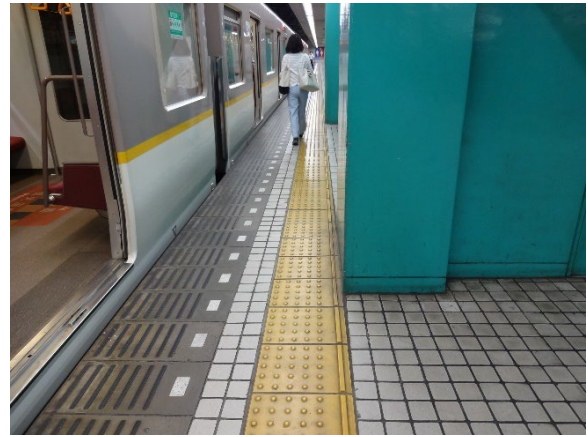
写真 22. 柱を回避するために警告ブロックの外側（線路側）を移動せざるを得ない (近鉄奈良駅)
