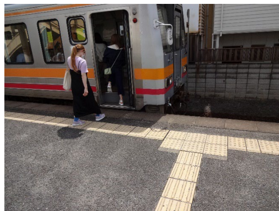
写真 8. 電車の先端よりも前に誘導ブロックが 設置されている (JR 法界院駅)
