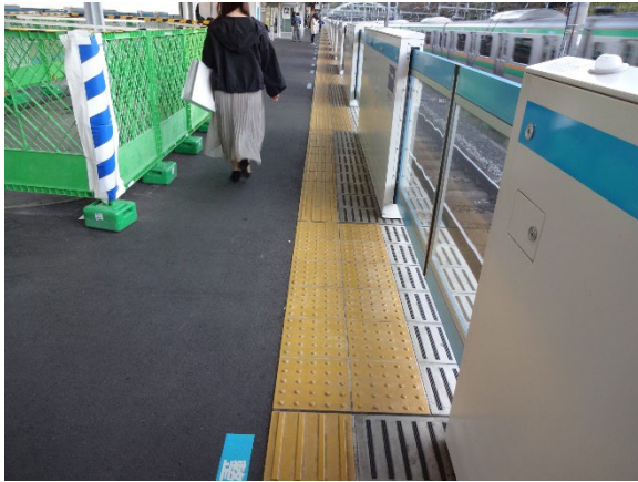
写真 39. ホームドアの前の点字ブロック 1 (JR 王子駅)
