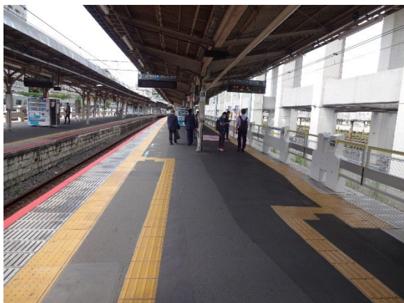
写真 30. 一方のホーム端にしかホームドアが設置されていない（JR 東十条駅）
