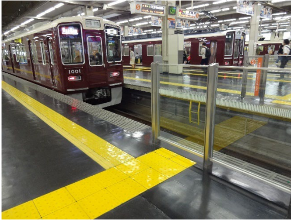
写真 34. 転落防止柵と電車の先頭の間に隙間がある（阪急梅田駅）
