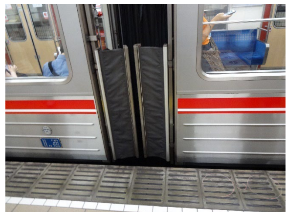
写真4. 車両の連結部に設置された転落防止幌 (大阪メトロ御堂筋線)
