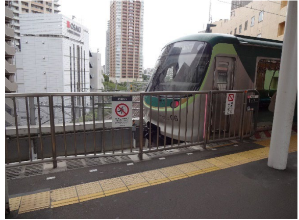
写真 35. 転落防止柵と電車の先頭の間に隙間がない（東急五反田駅）
