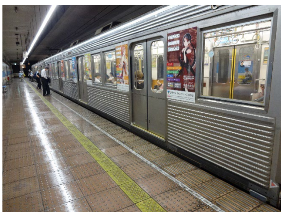
写真 14. 警告ブロックの幅が 20 cm しかなく、視覚障害者が検知できない（長野電鉄善光寺下駅）
