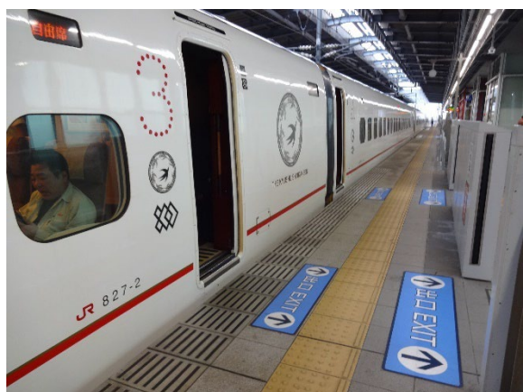
写真 32. ホームドアと車両の間に広い空間がある上に、ホームドアの内側に内方線付警告ブロックが設置されている（JR 久留米駅）
