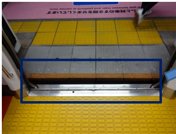
写真 28. ホームの縁端部に楡状のゴムを設置 (JR 恵比寿駅)
