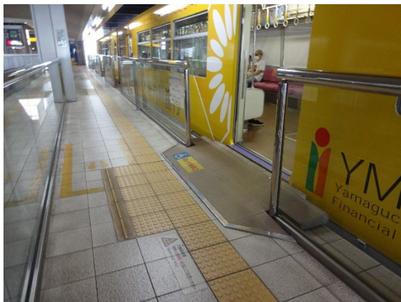
写真 29. 一部のドアの前にしかホームと電車の隙間の対策がなされていない (北九州モノレール小倉駅)
