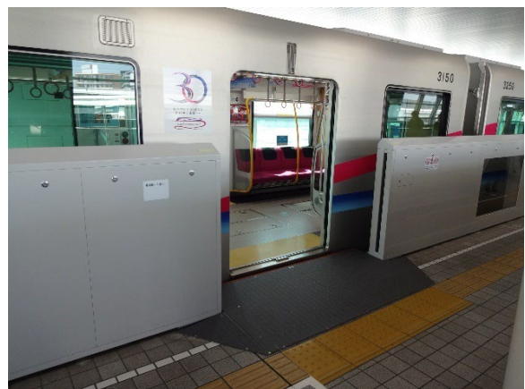
写真 27. ホームの縁端部の嵩上げ（大阪モノレール大阪空港駅）
