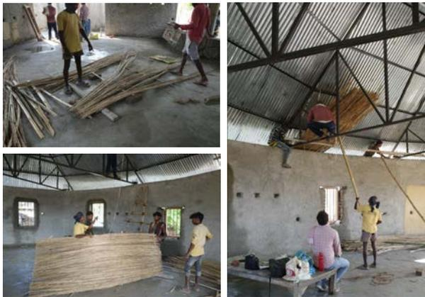
図 3 : 屋根下への茅パネル材の取り付けの様子
