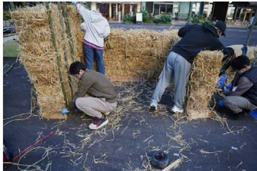
図6：ストローベイルを積み上げる時の様子
