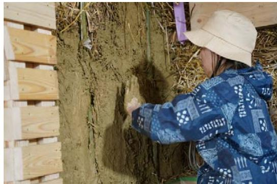
図10：ストローベイルワークショップの土壁塗りの様子
