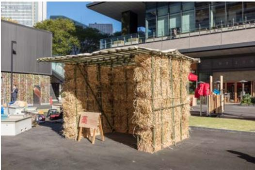
図5：ストローベイル構法による《藁のタイニーハウス》
