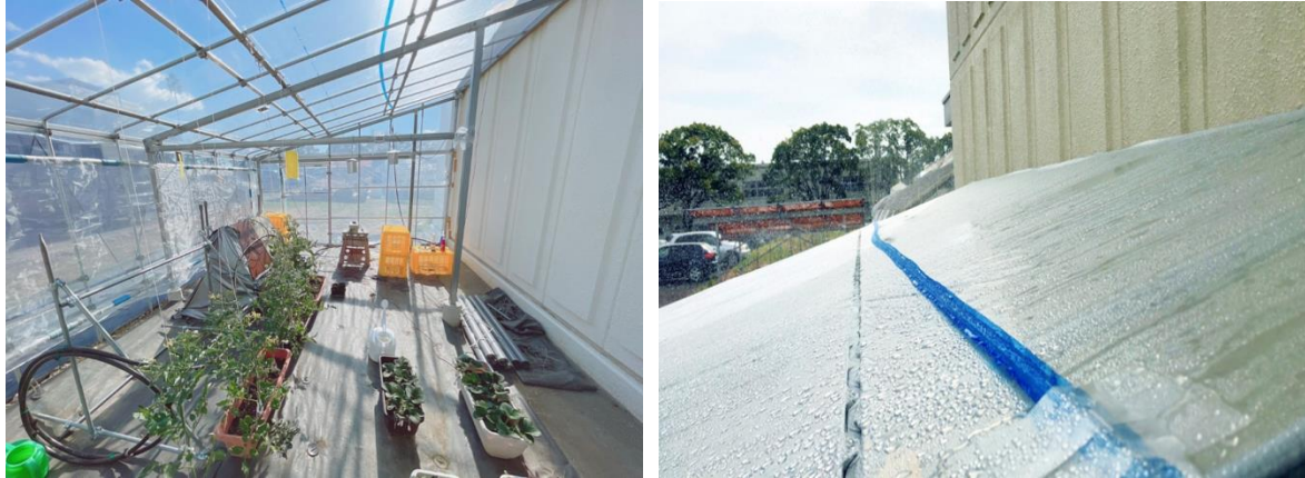
図3 温室内部の状況と散水チューブ設置状況
