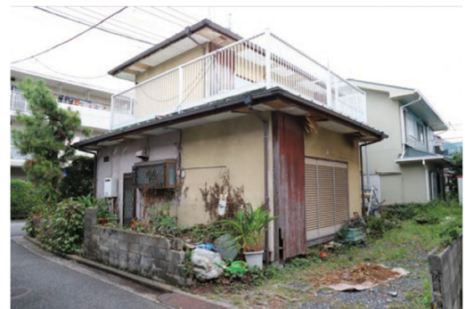
Fig. 2 既存建物の外観
