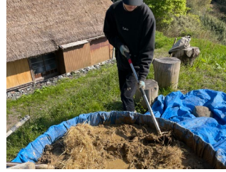
土壁用土練り
