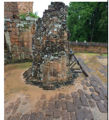
図1 遺構の崩壊状況 (イースト・メボン寺院小祠堂)
