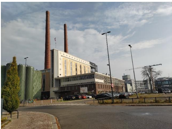
写真5 ストリップ-T イノベーションセンター
